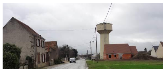
Entrée Nord marquée par les extensions récentes.
