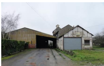
Ancien bâtiment d'entreprise
