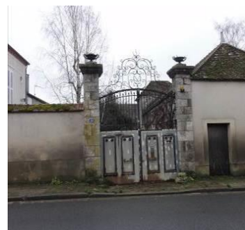
Portail avec ferronnerie travaillée
