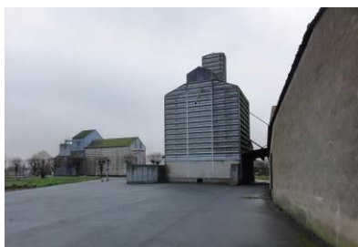
Silo de stockage de céréales
