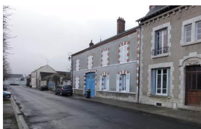
Bâti R + 1 – Avenue de la Gare
