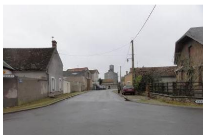
Silo en fond de perception
