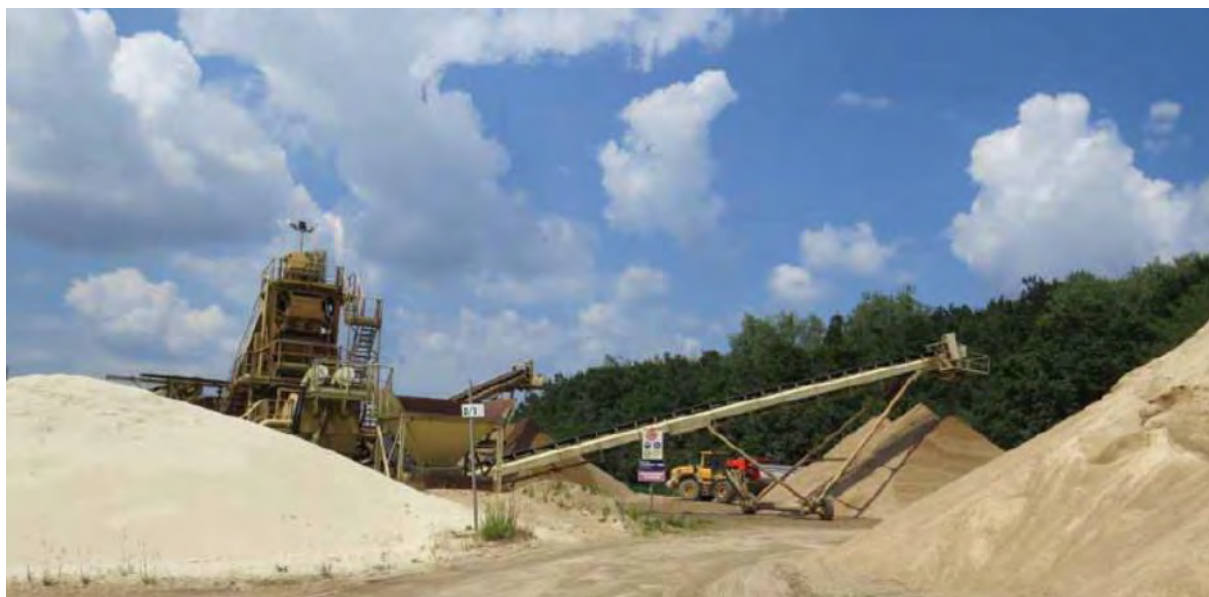
Figure 12 - Installations de traitement sur la carrière
