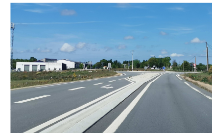
Absence de cheminement "doux le long de la RD 723 (entre la ZA et le bourg)
