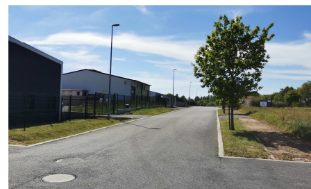
Cheminement "doux aménagé au sein de la ZA
