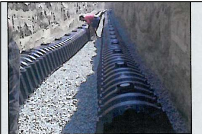
Tranchée d'infiltration (tunnels GRAF) Galati (Roumanie)
