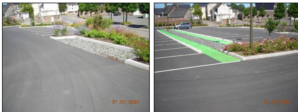
Photo 4 : Exemple de tranchées drainantes
