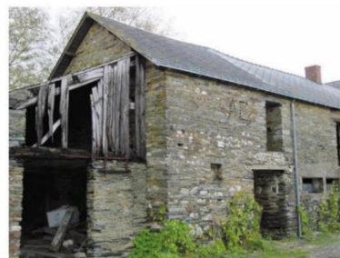
Le corps de ferme avant travaux
