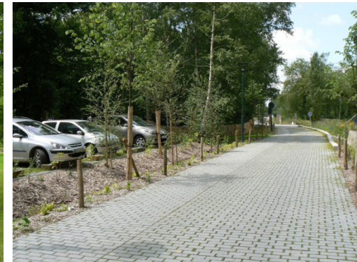
Gestion intégrée des eaux pluviales
