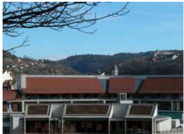
Toit végétal d'un lycée
