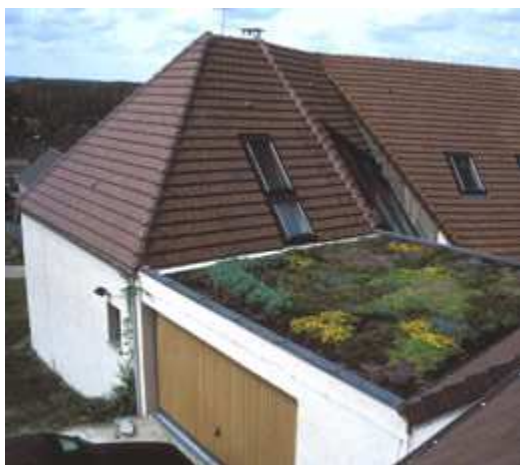
Toiture terrasse végétalisée
