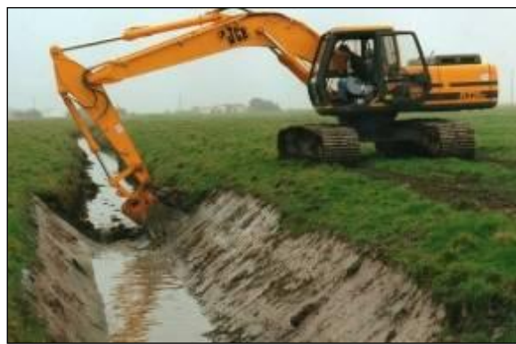
Figure 1 : Exemples de curage et reprofilage de fossé
