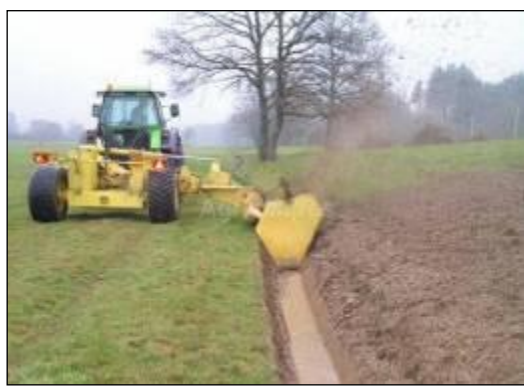
Figure 1 : Exemples de curage et reprofilage de fossé
