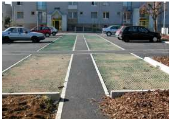
Structure réservoir recouverte d'un enrobé poreux
