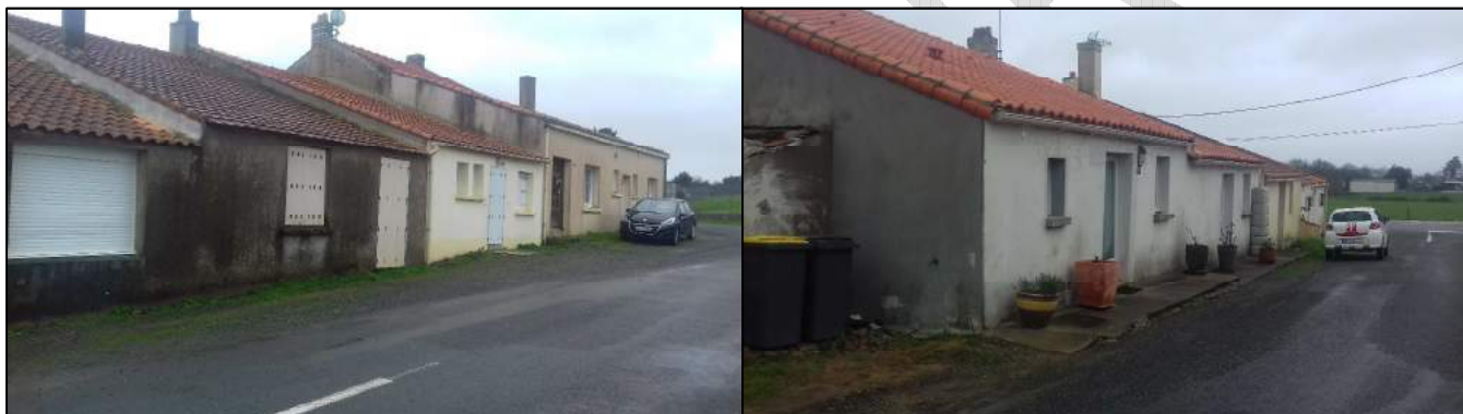
Vues du bâtiment principal
