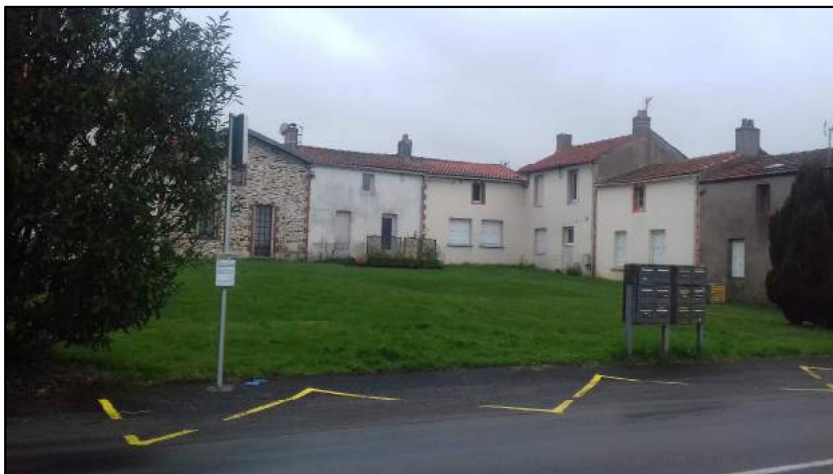
Photo 5 - emplacement envisagé pour le poste de refoulement
