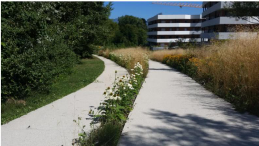
Figure 37 : Photo d’un exemple de stockage et d’infiltration des eaux pluviales le long d’un chemin piéton
