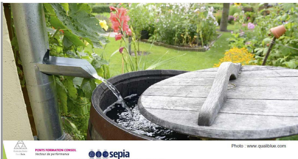
Figure 41 : Photo d'un exemple de stockage pour réutilisation en arrosage de jardin
