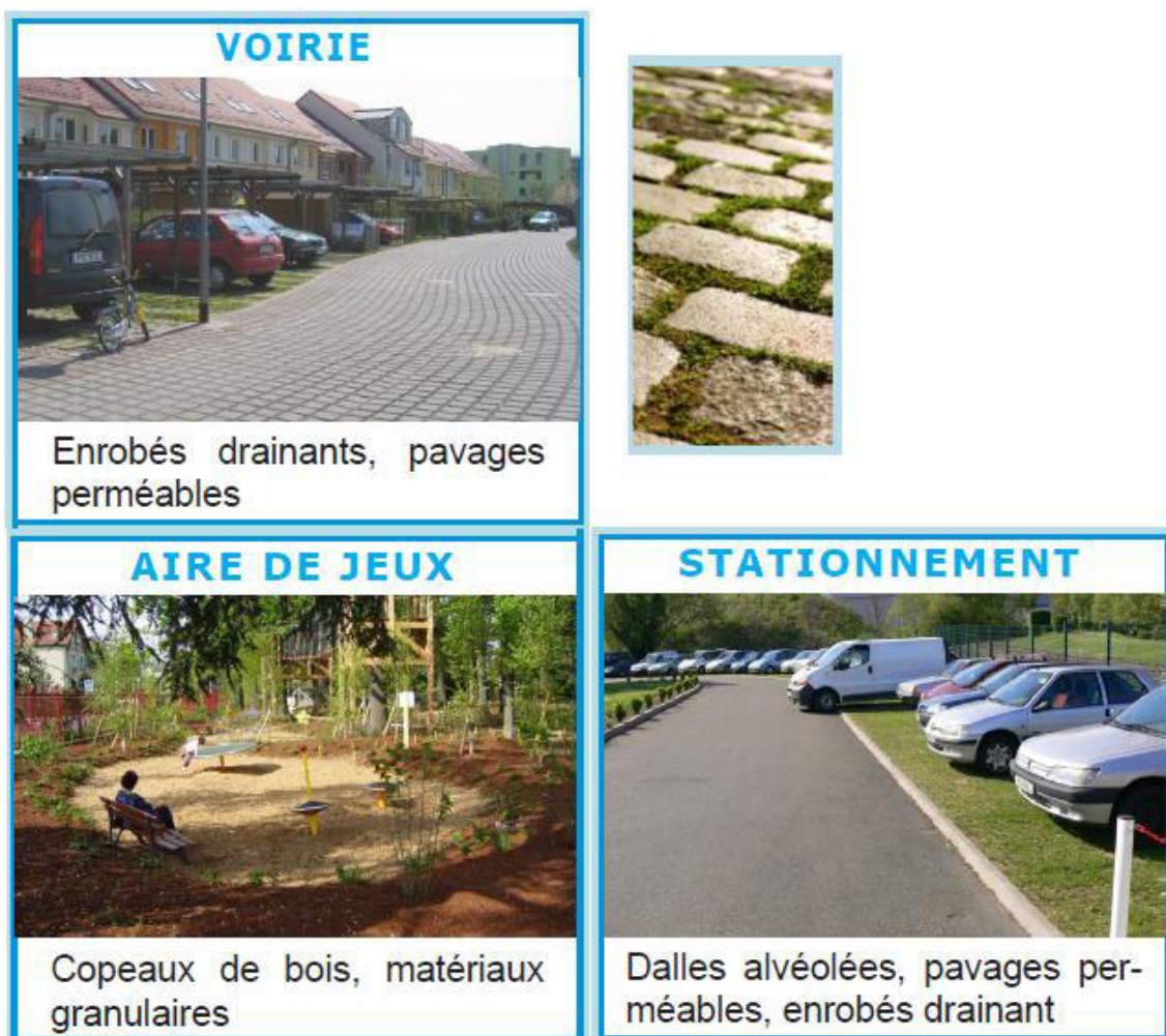
Figure 33 : Photos d'exemples d'alternatives à l'imperméabilisation du sol
