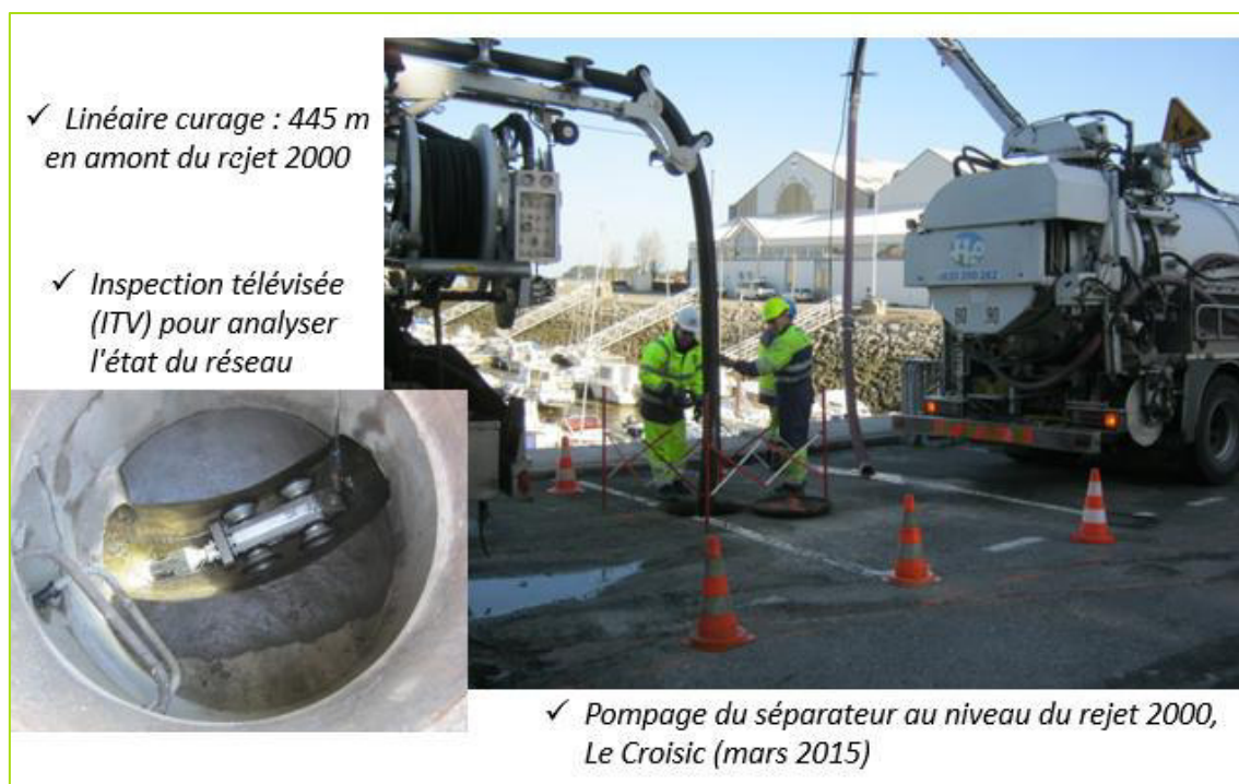
Figure 4 : Diagnostic et nettoyage de réseaux d'eaux pluviales
