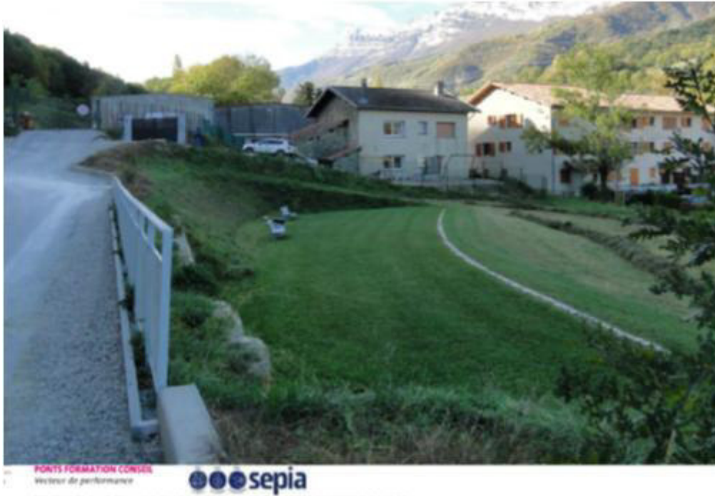
Figure 36 : Photo d’un exemple d’utilisation d’un espace vert pour le stockage et l’infiltration des eaux pluviales
