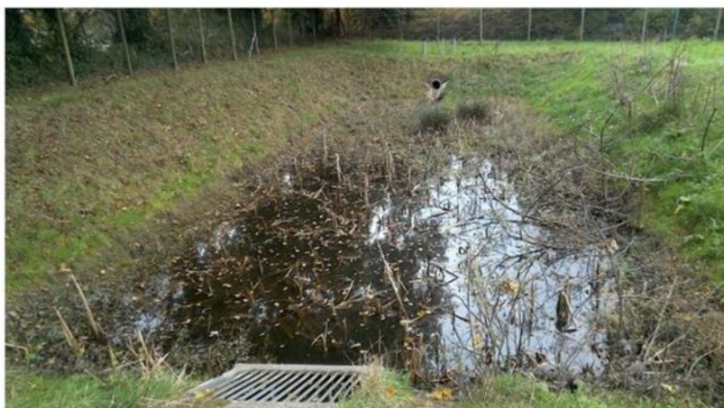
Figure 40 : Photo d'un exemple de traitement qualitatif intégré à un bassin de régulation du débit pluvial
