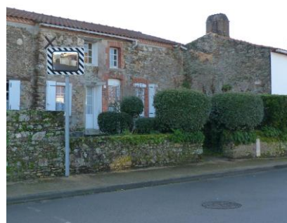
Muret de clôture, emmarchements...
