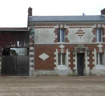
Maison de ville qui se démarque par une couverture en ardoise et un riche décor de façade (corniche pierre, motifs de briques,...)
