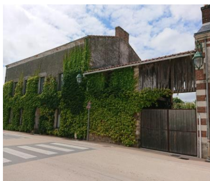
Maison de ville avec porche d'accès sur cour
