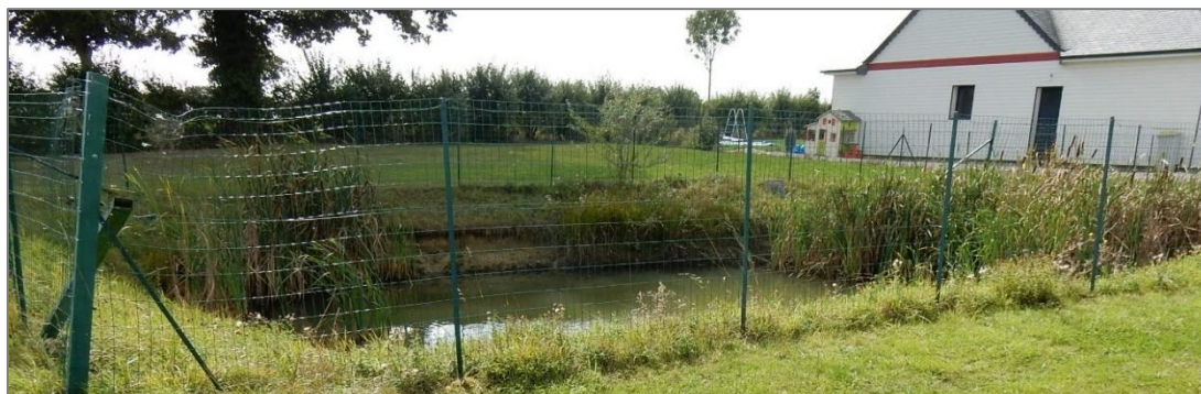
Photographie du petit bassin de rétention d'eaux pluviales
