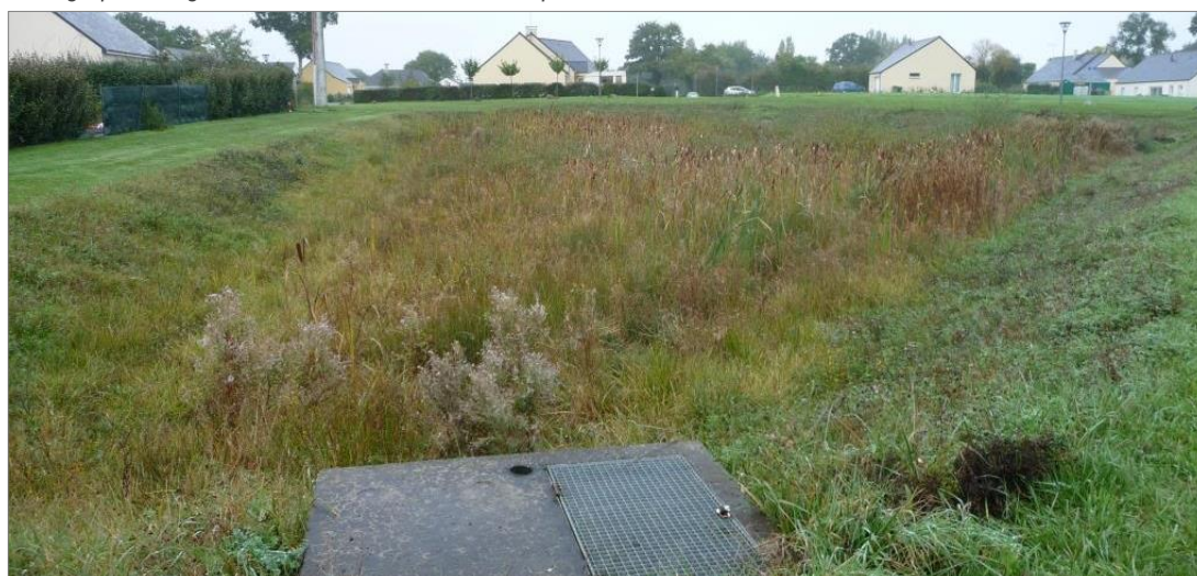
Photographie du grand bassin de rétention d'eaux pluviales
