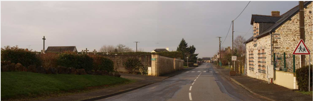
Muret en pierres du cimetière.
