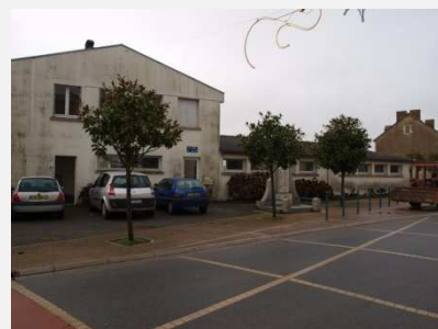
Aménagement (trottoir + voie) de la rue des Jonquilles.
