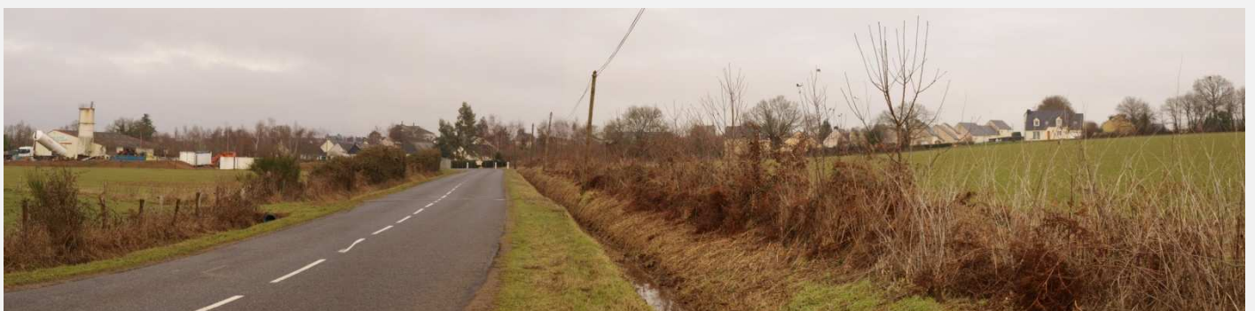
Entrée Sud par la RD 40 (le Brûlais), extension de l'urbanisation au Sud - Est du Bourg.
