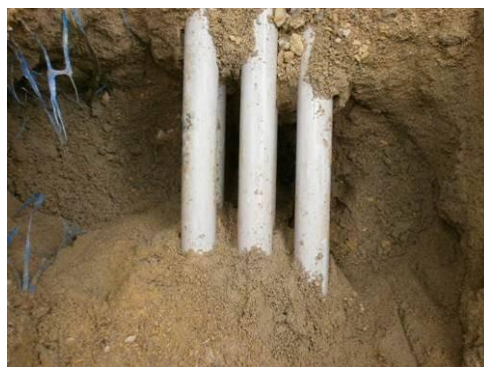
St Hilaire de Chaléons – La Maison Bertin : réseau télécom posé sur la conduite d'eau (impossible de faire le branchement)
