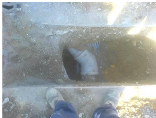
Machecoul – Rue Rochejacquelin : réseau gaz + pluvial sur conduite d'eau inaccessible
