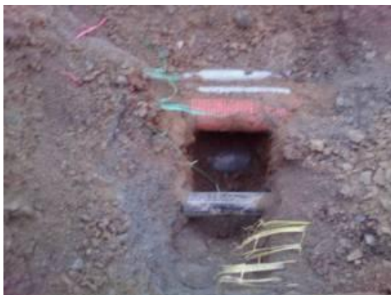
Sainte-Pazanne – Avenue des Frenchères : réseaux télécom + élec + gaz sur conduite d'eau
