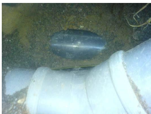
Machecoul – Rue Rochejacquelin : réseau gaz + pluvial sur conduite d'eau inaccessible
