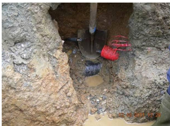
Machecoul – Route de la Forêt – réseau télécom posé sur la conduite d'eau
