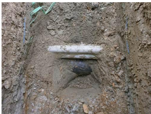
St Hilaire de Chaléons – La Maison Bertin : réseau télécom posé sur la conduite d'eau (impossible de faire le branchement)
