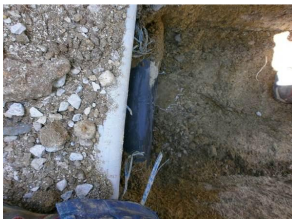
Machecoul – Route de la Forêt – réseau télécom posé sur la conduite d'eau
