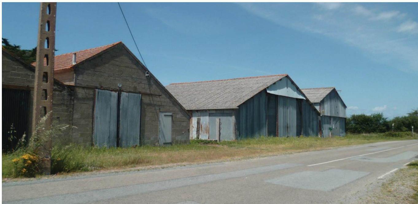
- Vue depuis la rue du Moulin sur les hangars implantés sur le secteur de projet -
