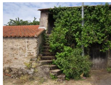
Escaliers extérieurs à la Bonfiserie
