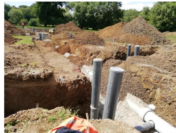
Etat des travaux sur le lotissement de Bauvet à la date du 17 mai 2021
