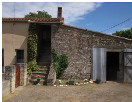
Escalier extérieur à La Quessière
