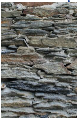
Maçonneries de moellons de schistes apparentes (absence d'enduit inappropriée)
