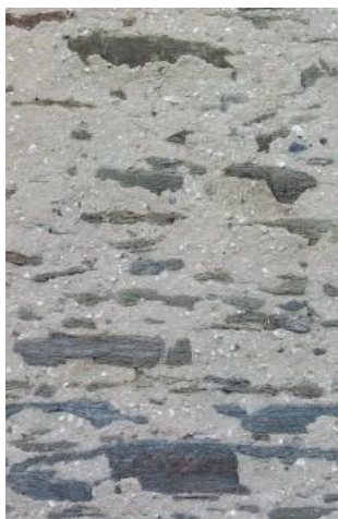
Enduit affeurant à pierres vues, avec pétard de chaux et mi-gnonnette (gros grain)
