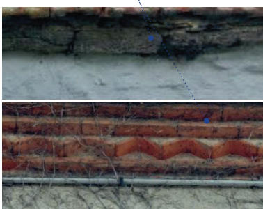
Corniche en dalles de schistes puis en génoise de briques
