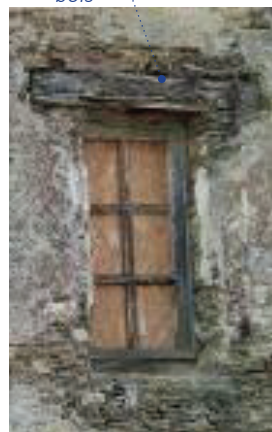
Lintheau droit soutenu par une poutre de bois
