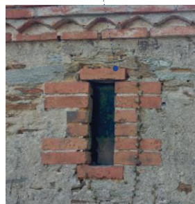
Corniche en dalles de schistes puis en génoise de briques
