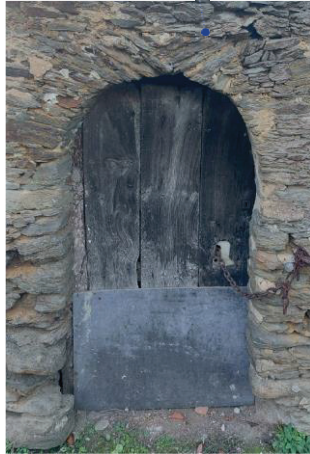
Lintheau monolithe délardé, en pierre de taille de schiste
