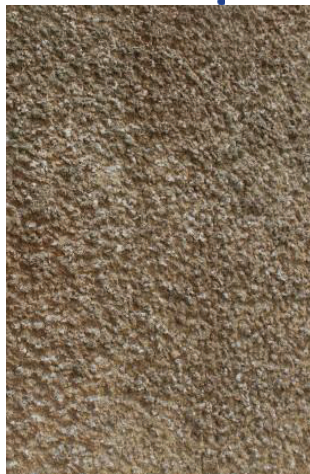
Enduit au ciment à mouchetis, également dit «à la tyrolienne»
