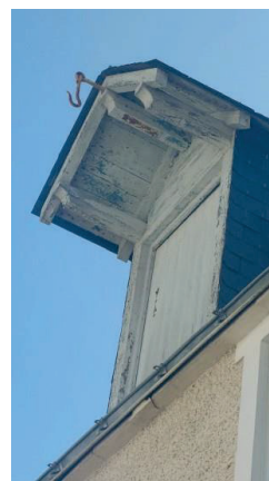
Pannes à abouts moulurés «en siffet»
