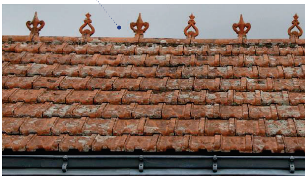
Tuiles à emboîtement dites «mécaniques» et faîtage décoratif
