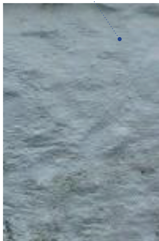
Enduit chaulé (recouvert de chaux blanche)
