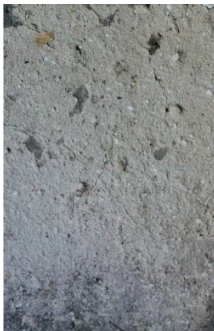
Enduit plein resserré, laissant apparaître quelques têtes de moellons
