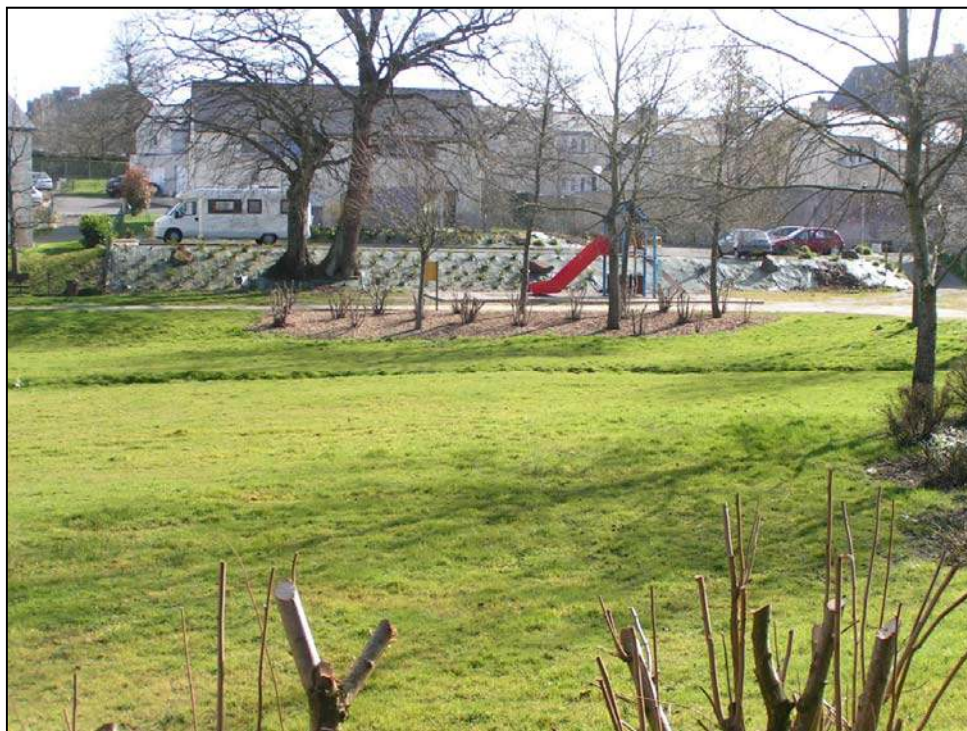
Figure 33 : Bassin pouvant servir d'aire de jeu lorsqu'il est à sec
