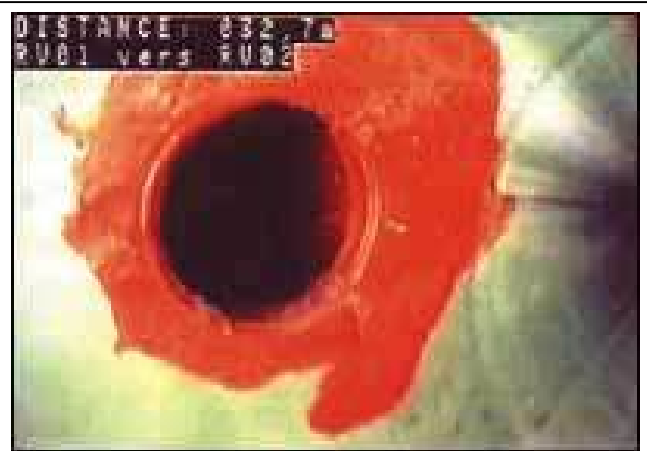
Inspection d'un branchement après intervention
