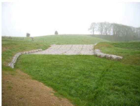
Figure 14 : Schémas et photographie d'un ouvrage de surverse
