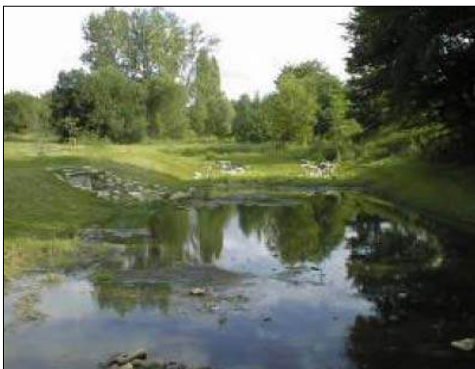
Figure 32 : Bassin paysager en eau
