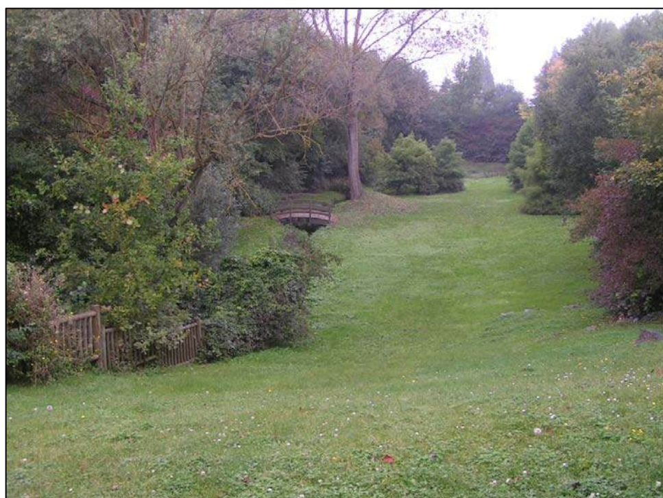
Figure 34 : Bassin servant de parc lorsqu'il est à sec
