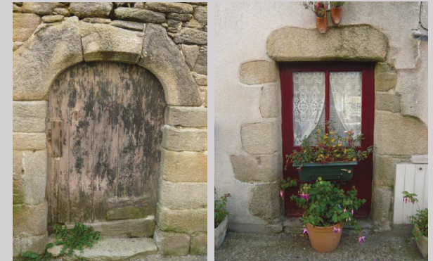
Préservation des percements d'origine
