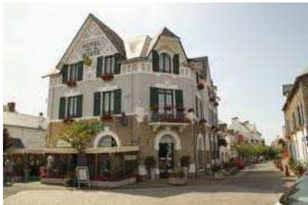
Hotel de la poste
