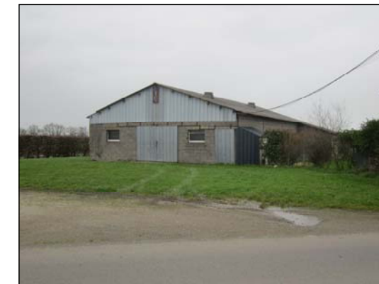
Hangar en tôle situé rue du Champ de Foire
