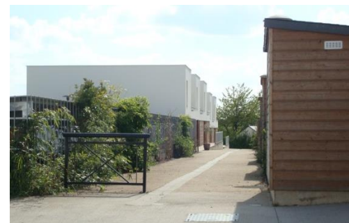
Ex: de voirie tertiaire
