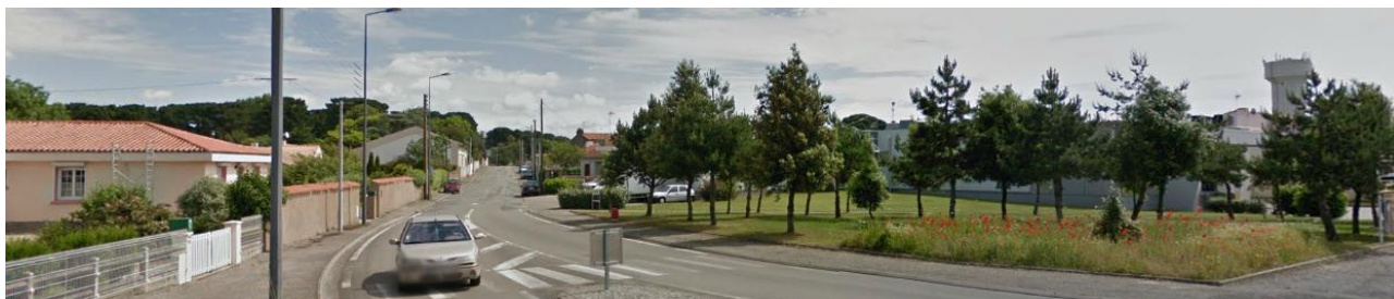
Entrée de ville Ouest – vue direction Paimboeuf
