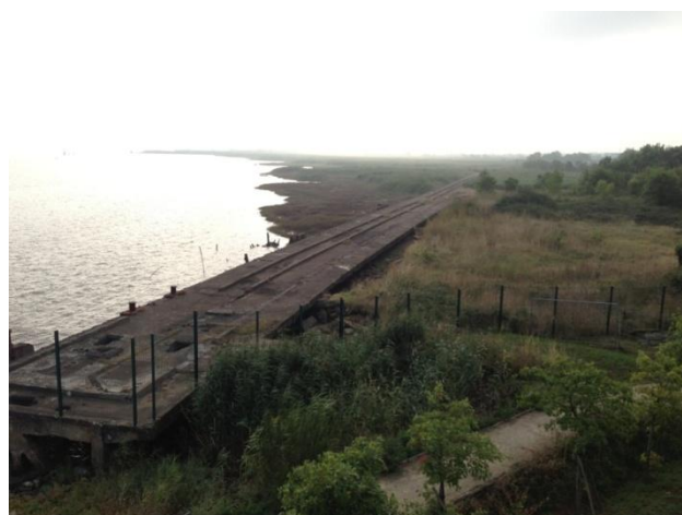
Site Natura 2000 à proximité de la friche industrielle de l'usine de Kuhlmann
