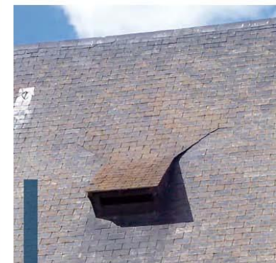
Chiroptière sur le toit d'une église
