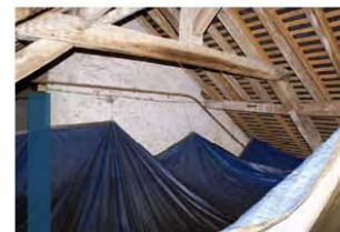
Bâches de protection dans un comble
