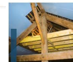
Installation d'un plancher
