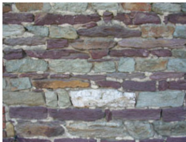
Alternance de schiste mauve et de blocs de grès, présence d'un élément de quartz
