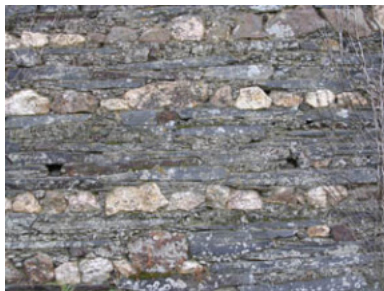
Maçonnerie de schiste avec insertion de blocs de quartz
