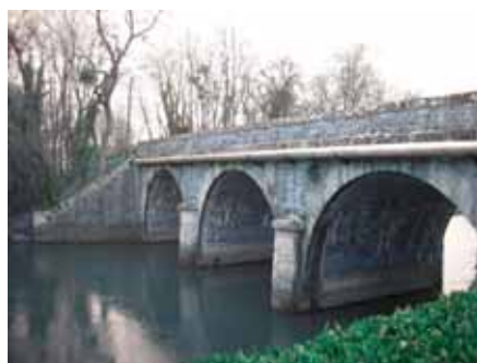
Photo 2 - Exemple de franchissement terrestre : les ponts.
