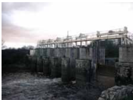
Photo 5 - Écluse du canal de Buzay (vue aval).
