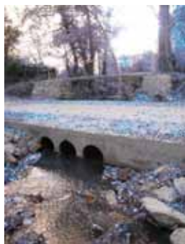
Photo 1 - Exemple de franchissement terrestre : les passages busés.
