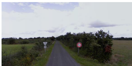
Voie communale Sud
