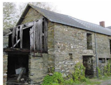
Le corps de ferme avant travaux
