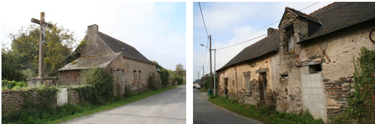
Figure 54 et 55 : Des logements vacants dans le hameau de Ruigné.
