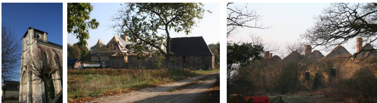
Figure 28, 29 et 30 : L'église, le manoir de la Jonchère en restauration et l'ancienne cité minière, un patrimoine à valoriser.
