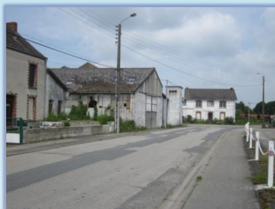
Ancienne activité Phospho-Gunao rue de la Gare
