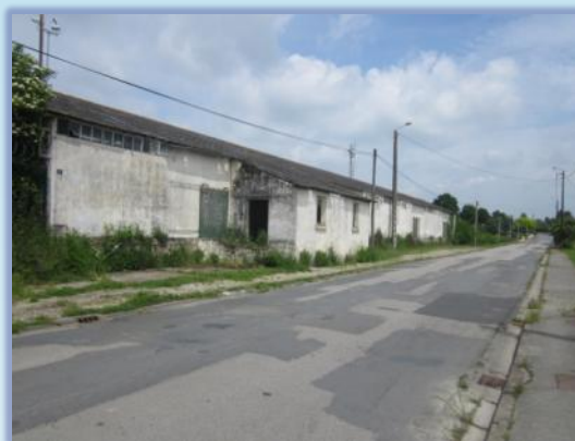
Friche d'activités rue de la gare
