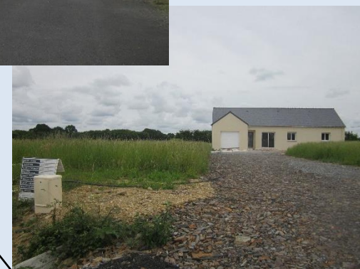
Maison récemment construite au Nord du village
