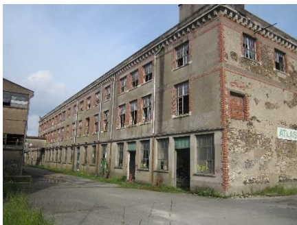
Ancien bâtiment de production, construit en 1940 (3 niveaux)
