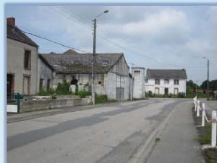
Ancienne activité Phospho-Gunao rue de la Gare
