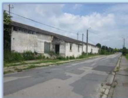
Friche d'activités rue de la gare
