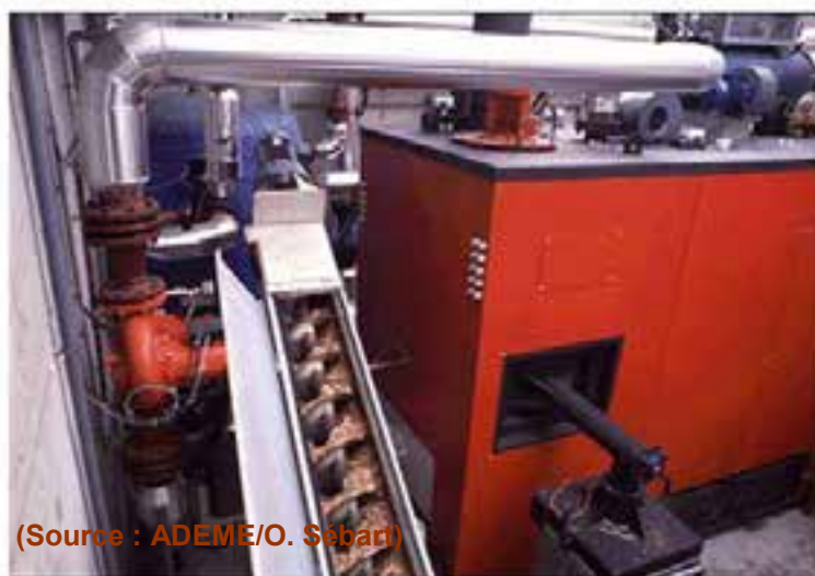
Arrivée du bois combustible dans une chaudière
