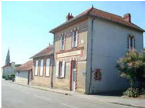
Vue sur l'ancienne école – Rue du Château
