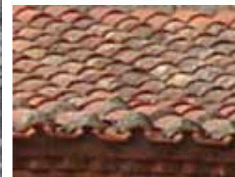
Couverture en tuiles dans l'habitat rural traditionnel
