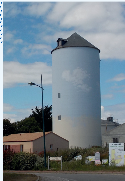
> Château d'eau de Rogère. 1000 m 3 , La Bernerie-en-Retz, rénové en 2016
