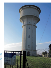
BOIS BRÛLÉ Réservoir sur tour 1 000 m 3
