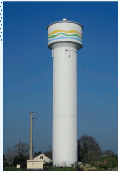
> Château d'eau de la Belle étoile 700 m 3 , Villeneuve-en-Retz (St Cyr), rénové en 2016.
