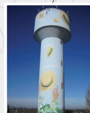
LES BRANDIÈRES Réservoir sur tour 2 000 m 3 Bâche 5 000 m 3 Station de surpression 720 m 3 /h
