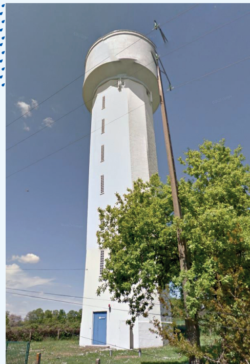
> Château d'eau La Paquelais à Vigneux-de-Bretagne – 500 m³ – 2017
