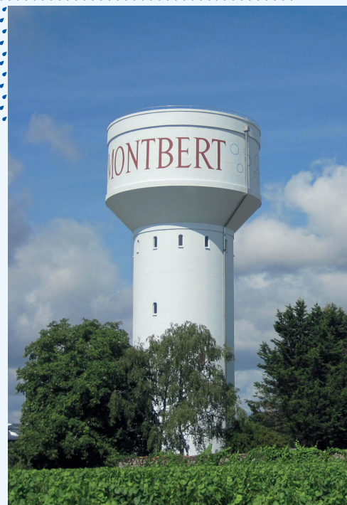
> Château d'eau du Butay à Montbert – 1 000 m³ – 2014
