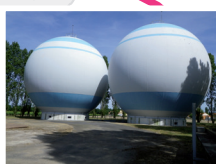
LES PEGERS Réservoirs hydropneumatiques 2 400 m 3 x 2
