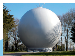
LA HARDIÈRE Réservoir hydropneumatique 2 400 m 3
