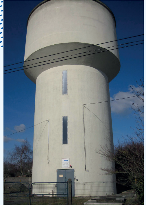
> Château d'eau de La Barre 500 m 3 le Cellier
