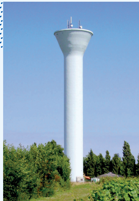
> Château d'eau La Chaloussière, 500m³ Vallet, 2008
