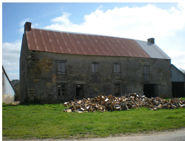
Construction sur Brandy
