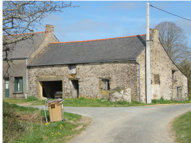
Constructions sur Barrisset et Brandy
