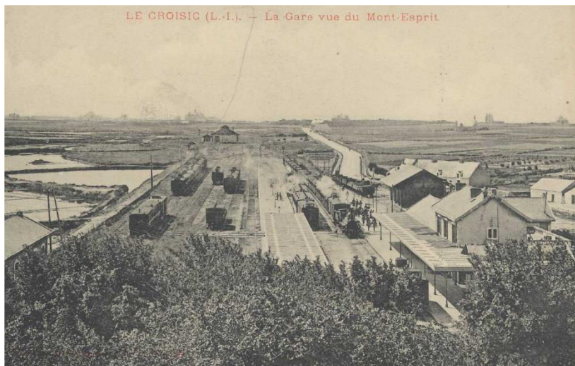
La gare vue du Mont-Esprit
