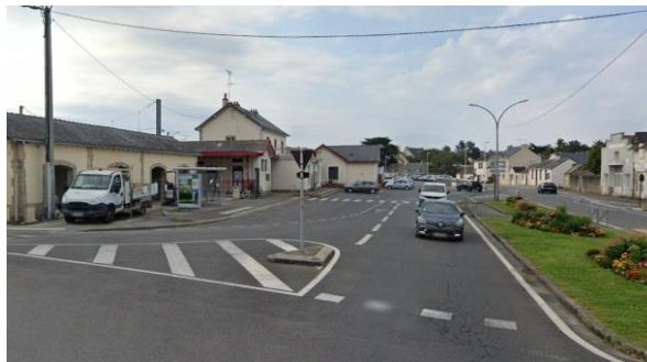
Abords de la gare du Croisic
