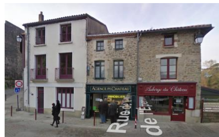
Perte de l'enduit, constitution d'un aspect « rustique » artificiel
