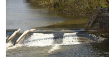
Chaussée du Pont de la Ville
