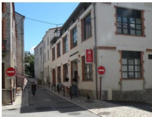
Repère des crues rue St Antoine
