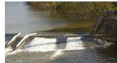
Chaussée du Pont de la Ville
