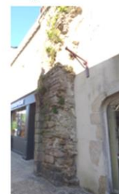
Vestiges d'une ancienne porte rue des Halles
