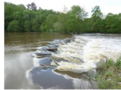
Chaussée et sauts de Gervaux
