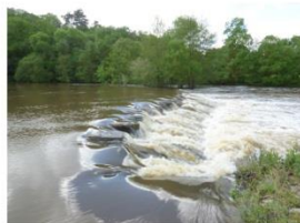
Chaussée et sauts de Gervaux
