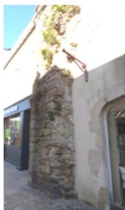
Vestiges d'une ancienne porte rue des Halles
