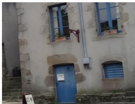
Le granite dans l'architecture locale
