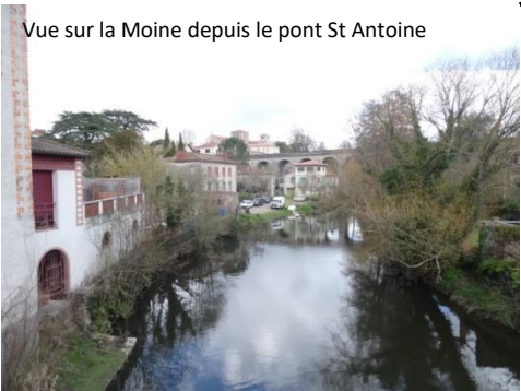
Le viaduc sur la Moine
