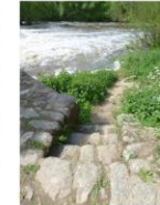
descente vers le canal de fuite
