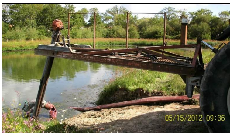
Pompage de la phase liquide
