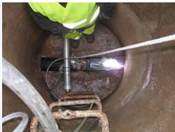
Mise en place dans un regard
