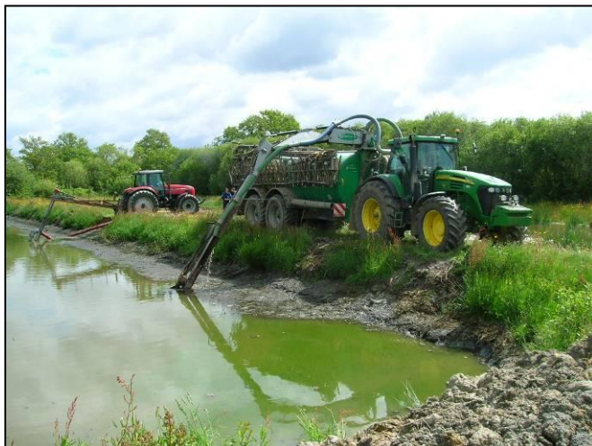
Pompage des eaux surnageantes
