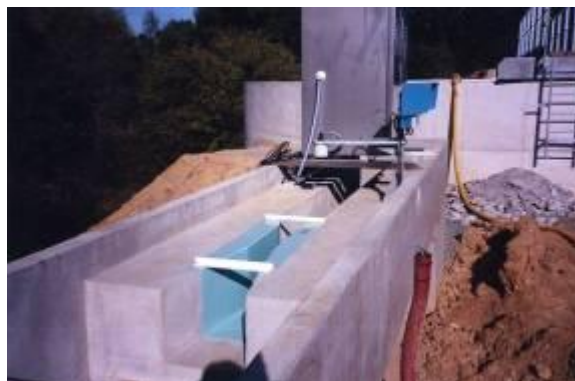
Débitmètre à ultrason
