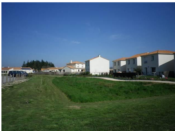
ZAC des Quarterons : les espaces verts sont vastes mais multifonctionnels : ici, ils servent de noues pour les eaux pluviales.
