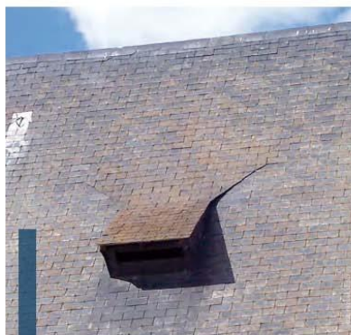
Chiroptère sur le toit d'une église.
