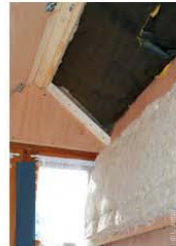
Construction d'un caisson isolé
