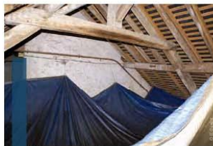
Bâches de protection dans un comble
