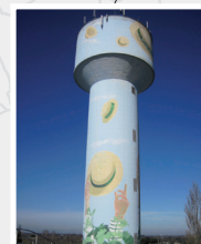
LES BRANDIÈRES Réservoir sur tour 2 000 m 3 Bâche 5 000 m 3 Station de surpression 720 m 3 /h
