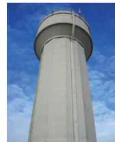
LES VERRERIES Réservoir sur tour 2 500 m 3
