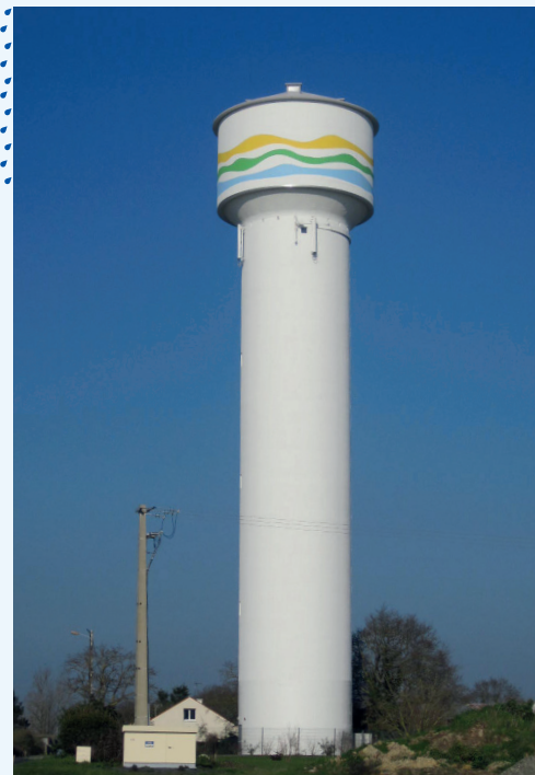
> Château d'eau de la Belle étoile, 700 m 2 , Villeneuve-en-Retz (St Cyr), rénové en 2016.
