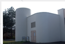
LA GARENNE Station de surpression 1 500 m 3 /h Réservoir au sol 5 000 m 3
