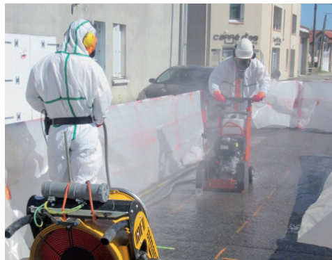
Rabotage d'enrobé amianté dans le cadre du renouvellement d'une conduite de diamètre 125mm en amiante-ciment Rue de Verdun St Philbert de Grandlieu, avril 2017.
