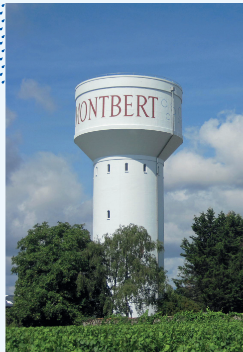
> Château d'eau du Butay à Montbert – 1 000 m 3 – 2014
