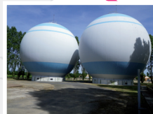
LES PEGERS Réservoirs hydro-pneumatiques 2 400 m 3 x 2
