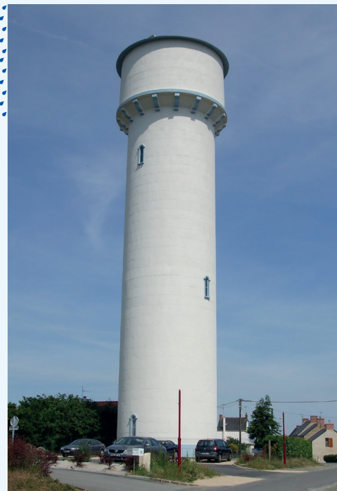
> Château d'eau La Haie-Mériaie 700m 3 , Campbon, rénové en 2009.
