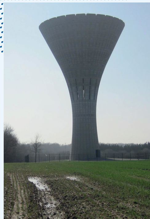
> Château d'eau de La Goulière. 2 500 m 3 , Saint-Mars-du-Désert, 2012
