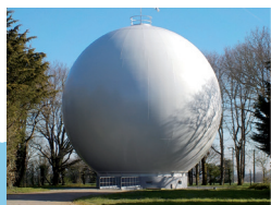
LA HARDIÈRE Réservoir hydro-pneumatique 2 400 m 3
