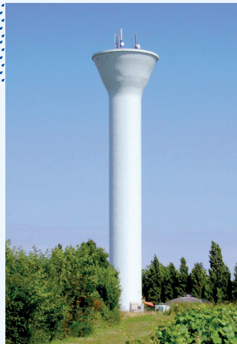
> Château d'eau La Chaloussière, 500m 3 Vallet, 2008
