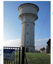
BOIS BRÛLÉ Réservoir sur tour 1 000 m 3
