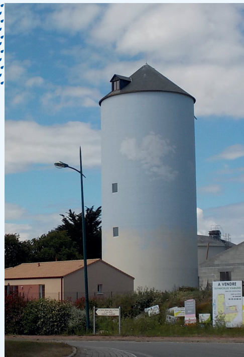
> Château d'eau de Rogère, 1000 m 3 , La Bernerie-en-Retz, rénové en 2016
