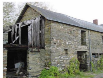
Le corps de ferme avant travaux
