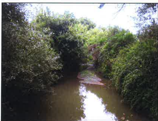
Sédimentation dans le lit mineur
