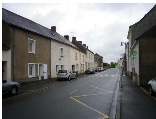
Rue du Prieuré : un espace très minéral
