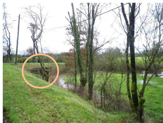
L'ouvrage 1, sous voirie routière
