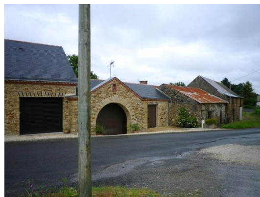
Bâtiment réhabilité aux Hautes Provostières
