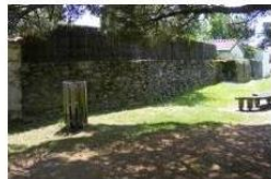
Balladins 7 - clôture seule
