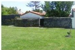
Balladins 5b - clôture seule
