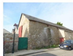
salorge visible rue de Kerdour
