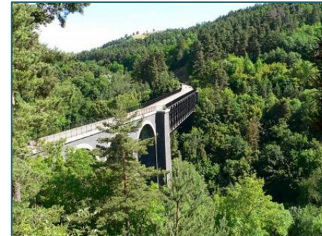
Viaduc de la Gagne
