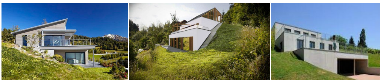
Exemple de constructions étagées, adaptées à la pente
