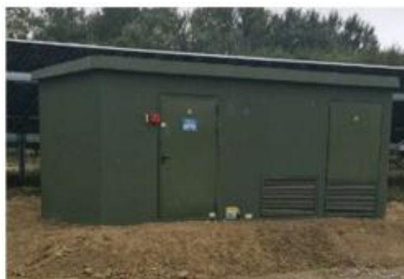
Source : © Enoe - étude d’impact pour le projet de parc photovoltaïque sur l’ancienne décharge de St-Christophe-sur-
