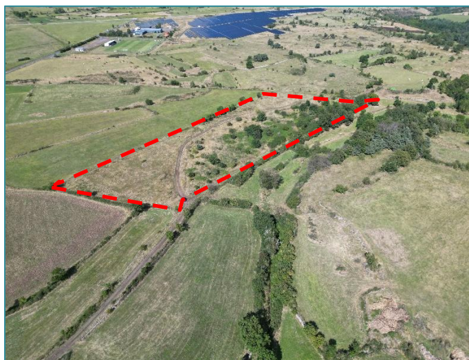
Vue de drone depuis le Sud-Ouest du site ©Campus Développement
