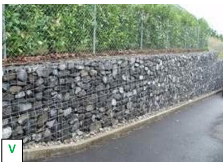
Muret en gabion
