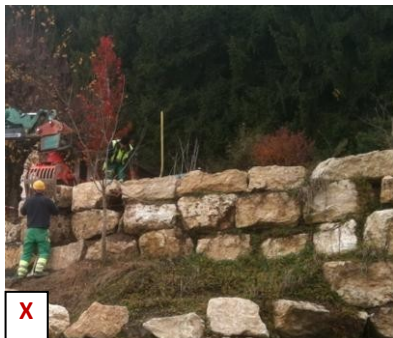
Enrochement de type cyclopéen
