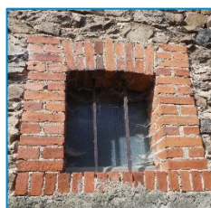
Ouverture avec encadrement en brique
