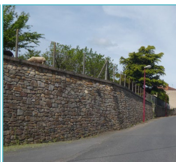
Mur de soutènement
