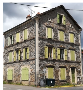
Bâtiment composé de 8 logements - La Ravel - Auvergne
