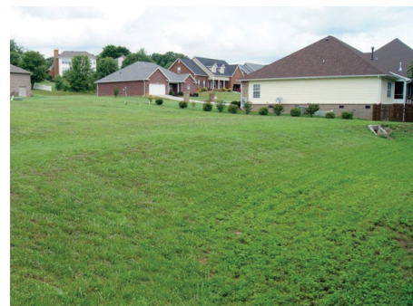
Deux bassins de rétention ouverts de différente taille, aménagés en parc. Ils font intégralement partie des espaces verts des habitations.
