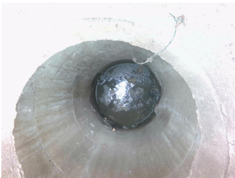
Mise en charge de la conduite en fonctionnement normal – Place de la paix
