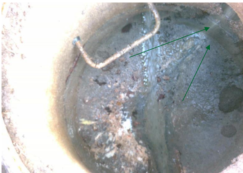
Lotissement de la Rivoire – Ecoulement permanent par un branchement
