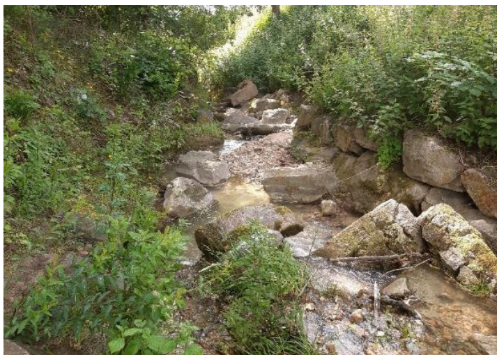
Photo prise le 18/06/20 – Enrochement déstabilisé
