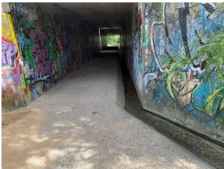
Photo prise le 18/06/20 – Présence de dépôts
