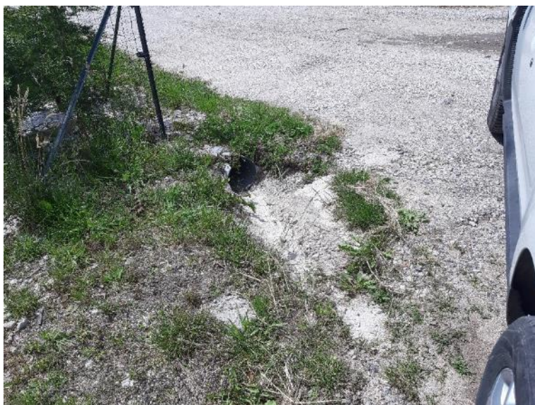
Photo prise le 18/06/20 – Tuyau PVC installé pour collecter les eaux de voirie
