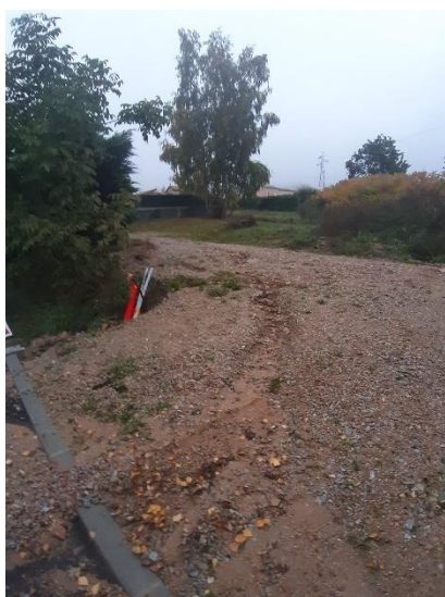
Photo prise le 29/01/20 – Bassin d'orage Melampyre 1
