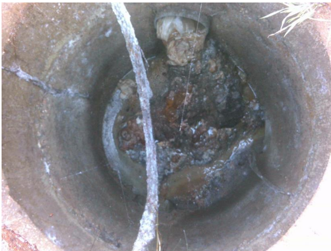
Intérieur du regard d'assainissement
