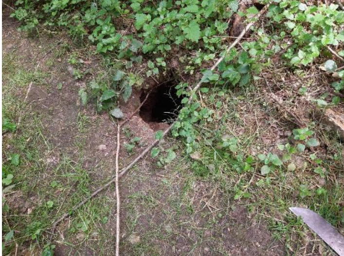
Photo prise le 18/06/20 – Canalisation visible au niveau du passage en rivière
