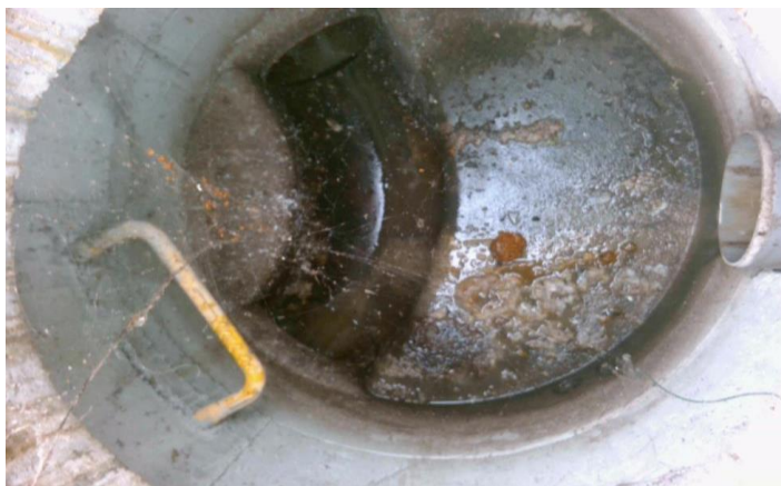
Photo du réseau d'eaux pluviales
