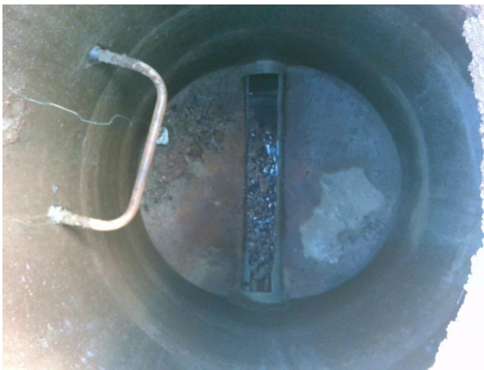
Intérieur du regard d'assainissement
