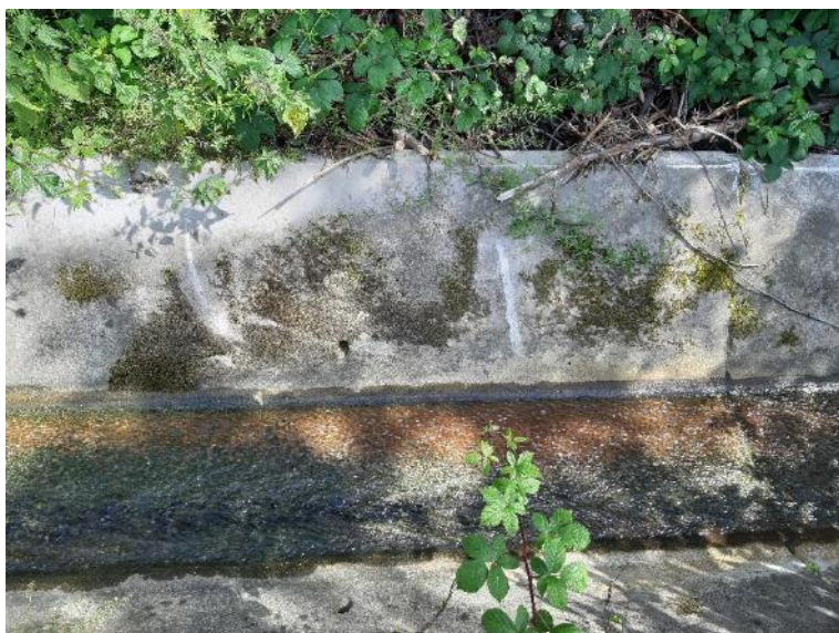
Photo prise le 18/06/20 – Passage sous la RN88
