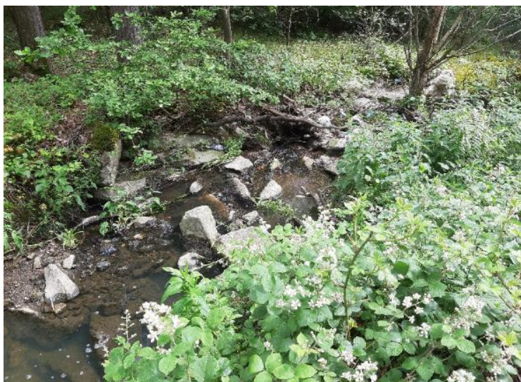
Photo prise le 18/06/20 – L'enrochement est partiellement tombé dans le lit du ruisseau
