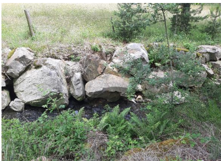
Photo prise le 18/06/20 – L'enrochement est partiellement tombé dans le lit du ruisseau
