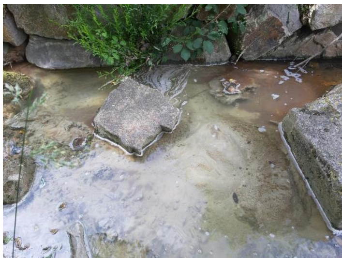
Photo prise le 18/06/20 – Enrochement déstabilisé
