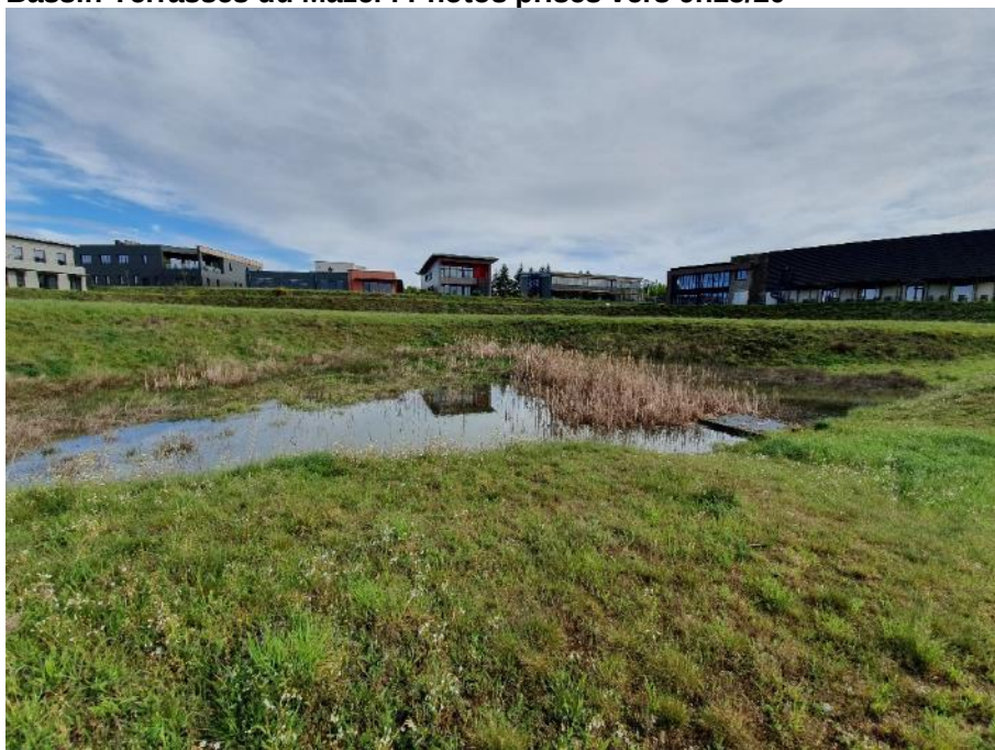
Bassin Terrasses du Mazel : Photos prises vers 9h15/20
