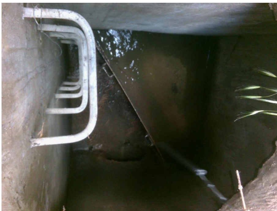
Mise en charge de la conduite en fonctionnement normal – Rue Henri Pourrat
