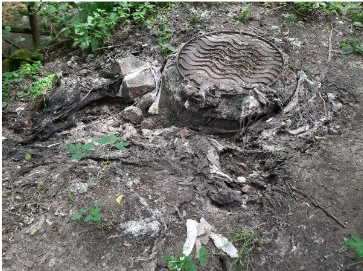
Photo prise le 18/06/20 – Traces de débordements au niveau des regards
