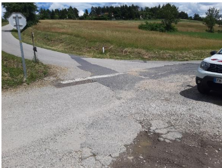
Photo prise le 18/06/20 – Vue de la descente des Chenanches avec double fossé de chaque côté de la route
